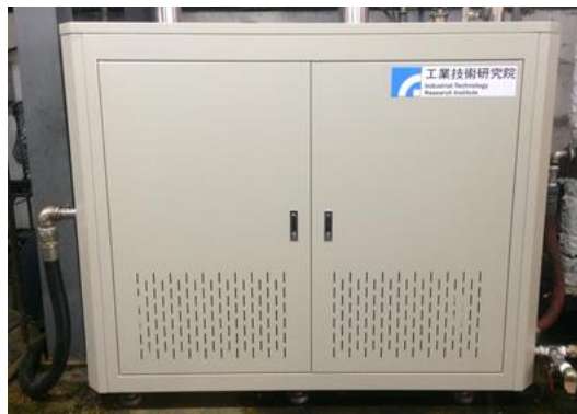
5 kW模組化熱電系統(輪胎廠)
