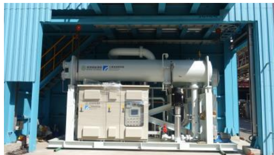
台化200kW螺桿式ORC廢熱回收發電系統 中鋼200kW 螺桿式ORC煙氣熱能回收發電系統
