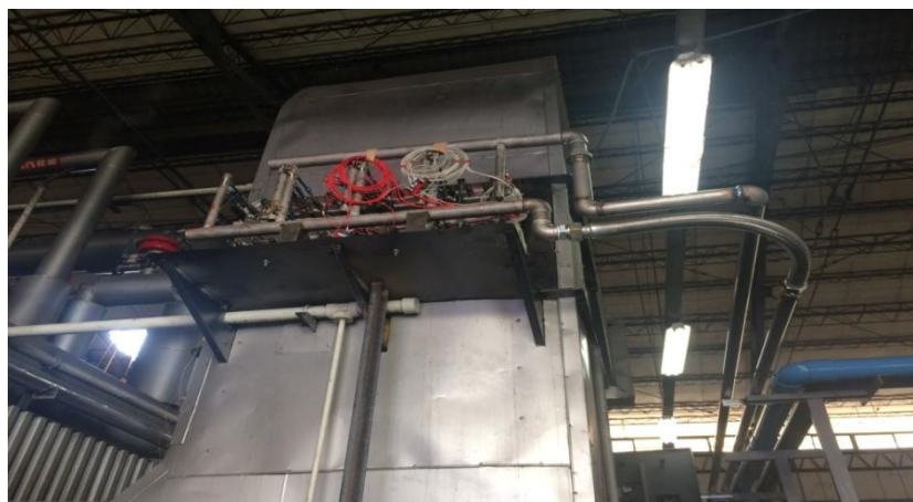
煙器回收2KW發電
