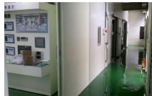
平衡型空調機性能實驗室
