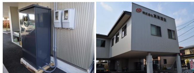
日本家用型微電網系統及電能管理系統
