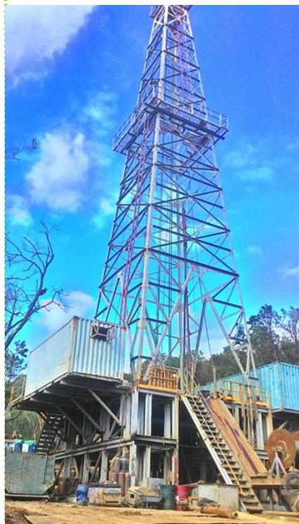
四磺子坪鑽井工程施工
